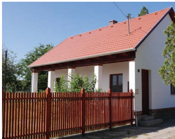
A mórabalmi felújított egykori ONCSA-ház
